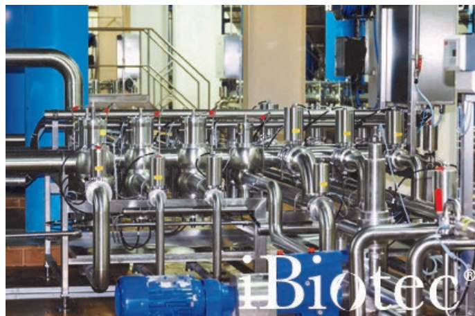
Limpieza de capas de tuberías de distribución en industrias agroalimentarias
